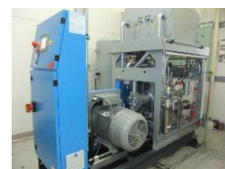
回収ヘリウムガス圧縮機
