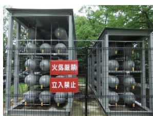
回収ヘリウムガス高圧貯蔵容器
