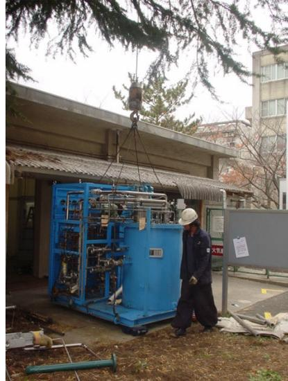
(写真2) 旧ヘリウム液化機撤去の様子
