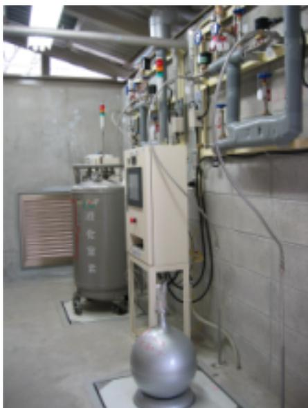
(写真5) 液体窒素自動充填システム
